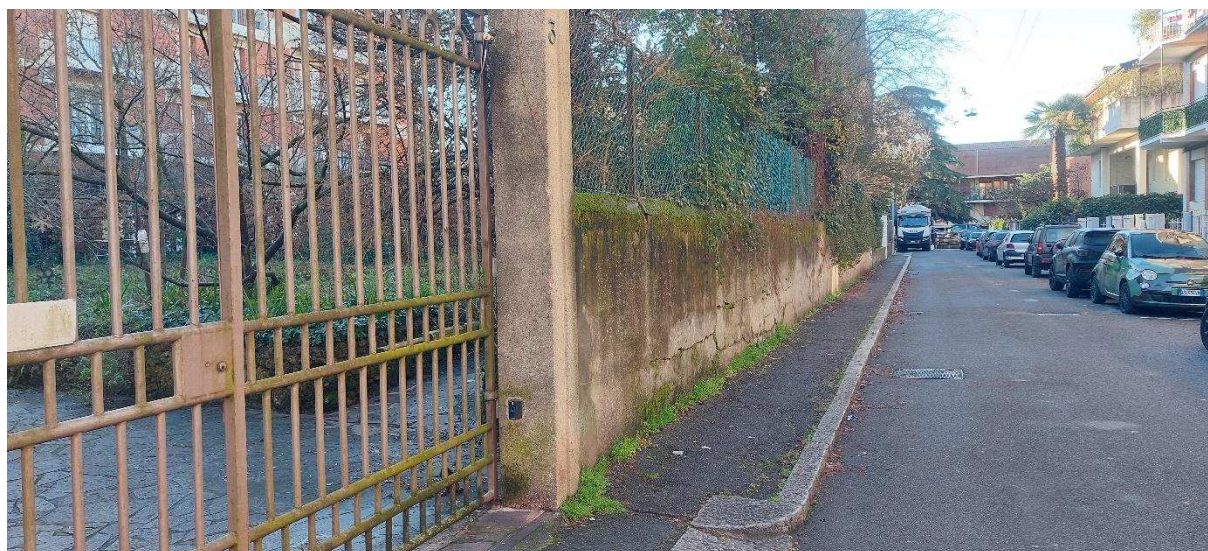
Recinzione con elevata componente muraria
