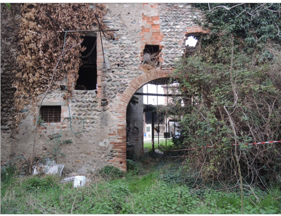
L muratura perimetrale in ciottoli di fiume disposti a lisca di pesce; portale di accesso alla corte comune con architrave in mattoni cotti pieni
