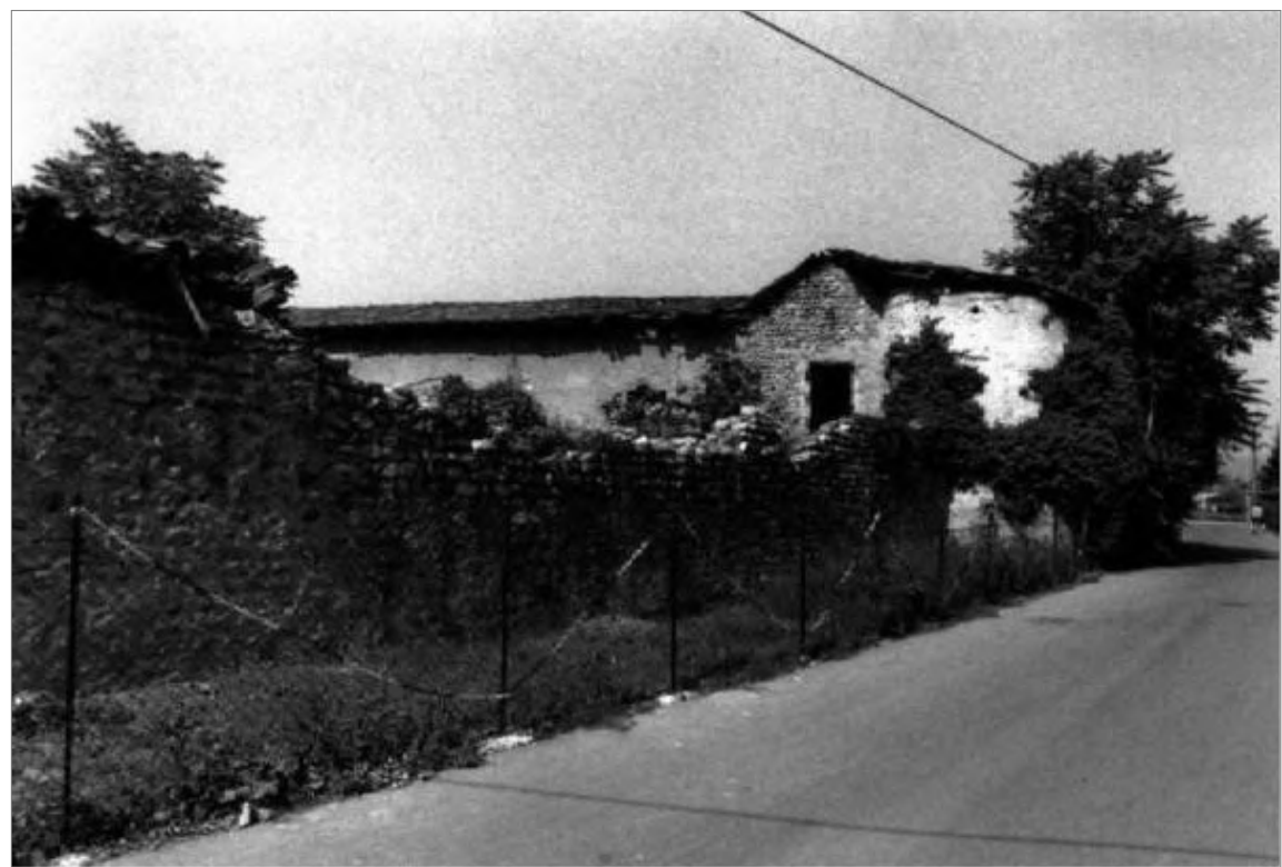
1. FOTOGRAFIA STORICA: MURATURE PERIMETRALI e scorcio del TORRIONE ROTONDO da via Giovanni Falcone e Paolo Borsellino
