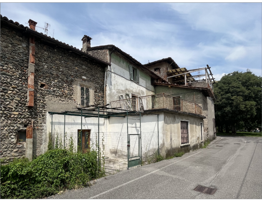
R fabbricato esistente in muratura con soprastante terrazza di postuma realizzazione
