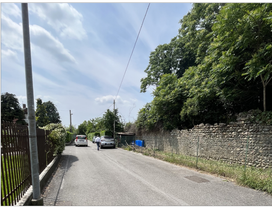
N muratura perimetrale in ciottoli di fiume disposti a lisca di pesce
