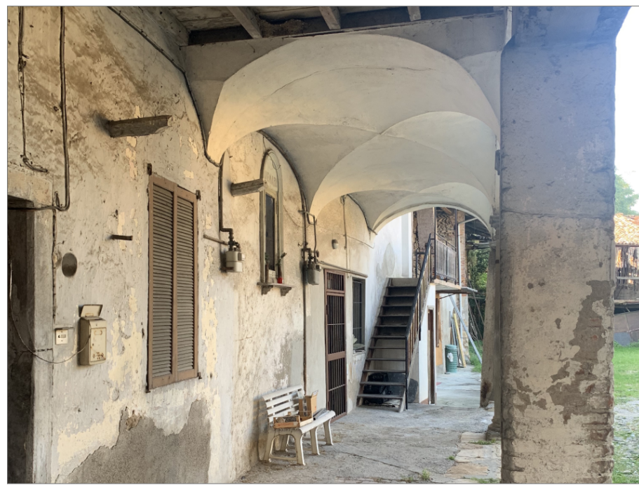
C volta a crociera del portico
