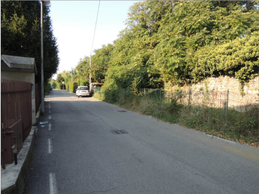
04 muratura perimetrale fronte via G.Falcone e P.Borsellino in ciottoli di fiume disposti a lisca di pesce
