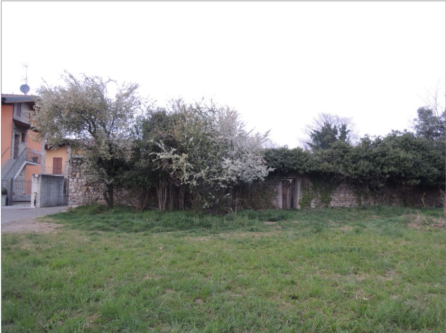
05 muratura perimetrale in ciottoli di fiume disposti a lisca di pesce
