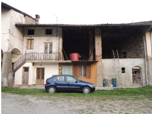
fabbricato ad uso agricolo caratterizzato da muratura perimetrale in ciottoli di fiume disposti a lisca di pesce e pilastri in mattoni pieni in laterizio con copertura in legno e manto di copertura in coppi
