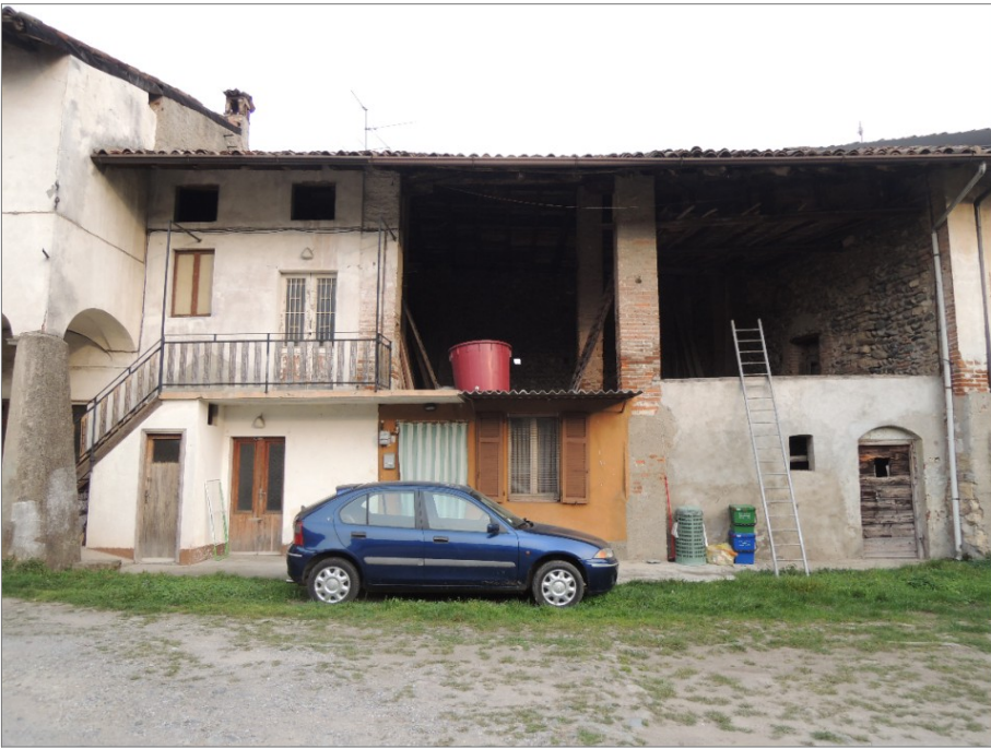
E fabbricato ad uso agricolo caratterizzato da muratura perimetrale in ciottoli di fiume disposti a lisca di pesce e pilastri in mattoni pieni in laterizio con copertura in legno e manto di copertura in coppi
