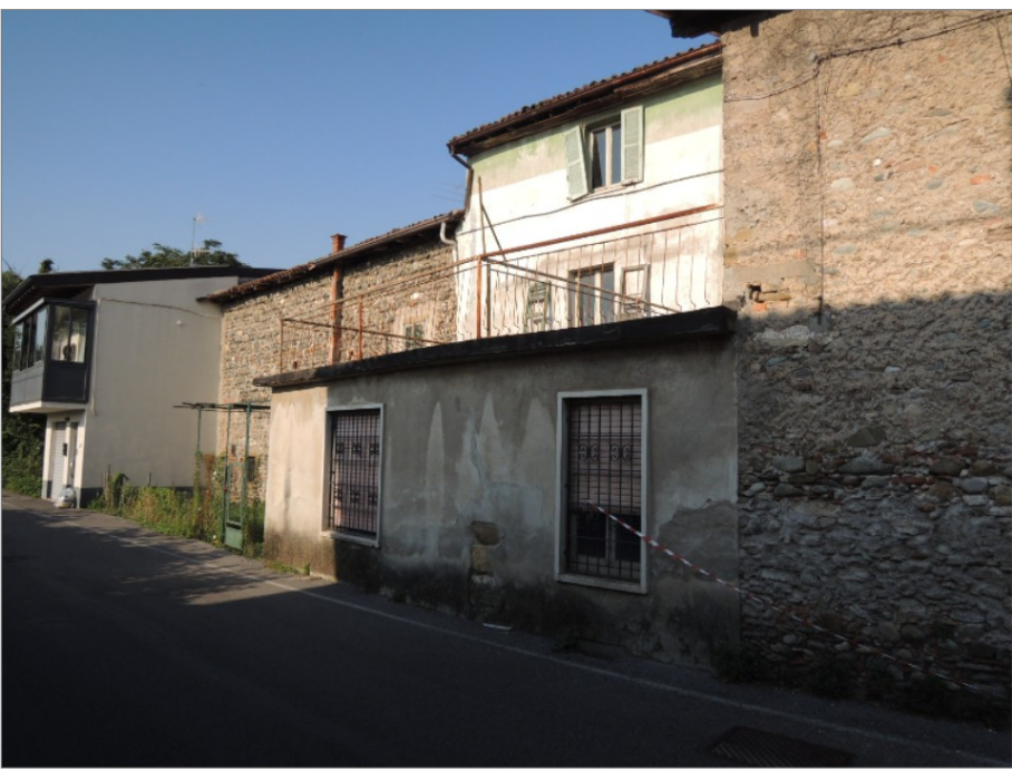
07\EDIFICIO DESTINAZIONE RESIDENZIALE - incongruenza materica rispetto al complesso edilizio; - realizzazione postuma
