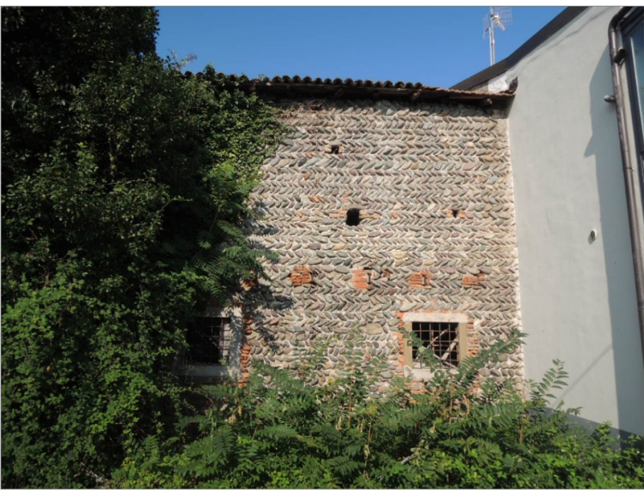
P fabbricati fronte strada via G.Falcone e P.Borsellino realizzati in ciottoli di fiume disposti a lisca di pesce
