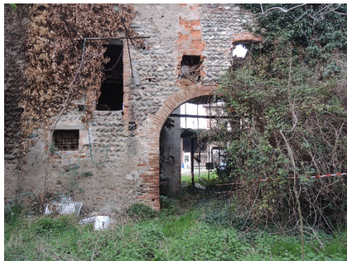
muratura perimetrale in ciottoli di fiume disposti a lisca di pesce; portale di accesso alla corte comune con architrave in mattoni cotti pieni
