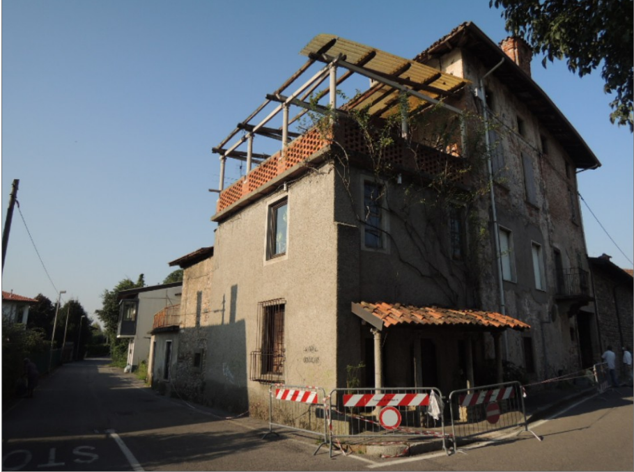
02 edificio religioso con soprastante terrazzo coperto da struttura metallica e legno di postuma realizzazione
