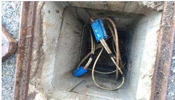
Interno pozzetto con giunzione gel
