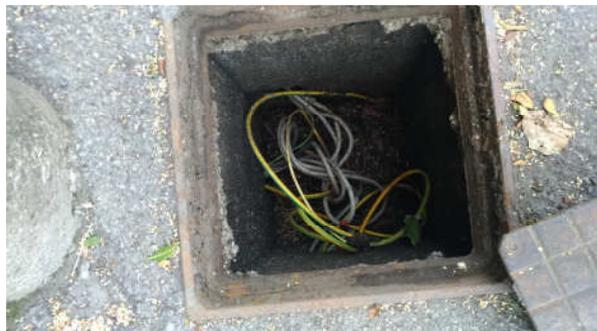
Interno pozzetto senza giunzioni
