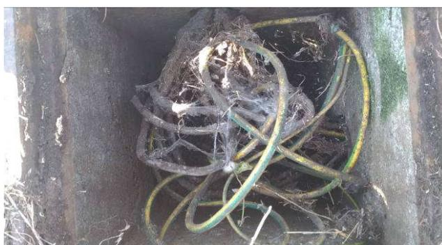
Interno pozzetto senza giunzioni
