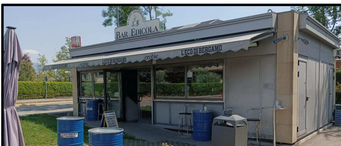
Via Donizetti – Edicola rivendita quotidiani e periodici abbinata a esercizio pubblico di somministrazione di alimenti e bevande – Non trattasi di chiosco ma di prefabbricato posizionato su area pubblica costituente un locale accessibile dal pubblico per il consumo
