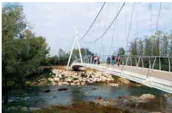
*Ponte sospeso su funi paraboliche, costruito in acciaio e impalcato in legno*
